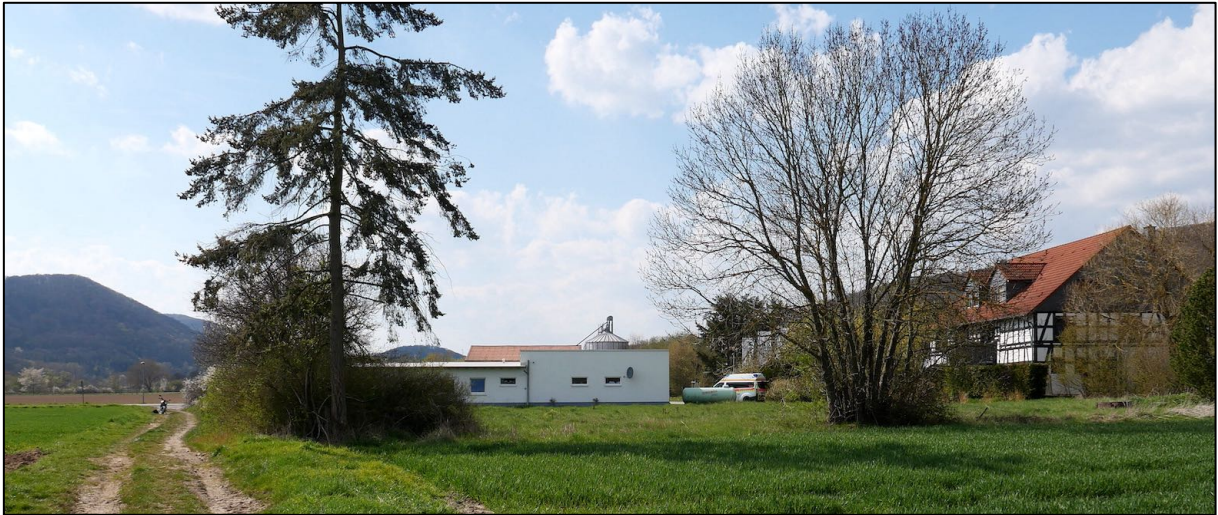
Abbildung 2: Ansicht der Erweiterungsfläche vor dem Rettungswache-Gebäude, Blick RI W (04/2021)
