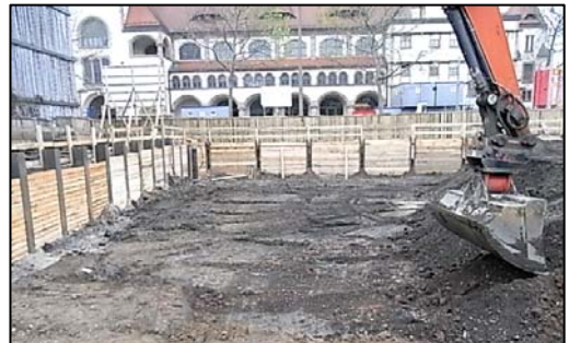
Abb. 4. Schichtenweiser Abtrag, verpflichtend bei baubegleitender KMR
