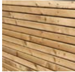
HOLZVERKLEIDUNG an Hauptzugängen
